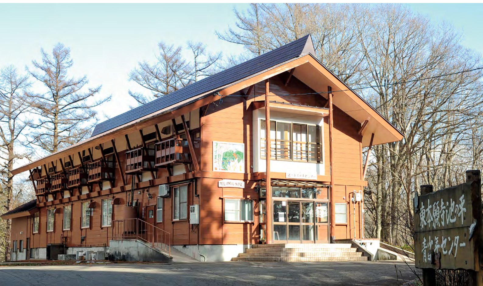
池の平青少幼年センター改修工事完了
